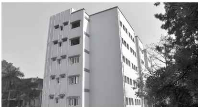
निर्माणाधीन नवीन प्रयोगशाला भवन
